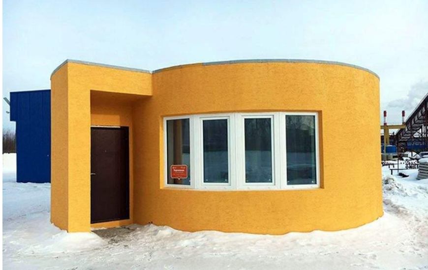
Slika 24. Kuća za 24 sata isprintana 3D printerom[21]
